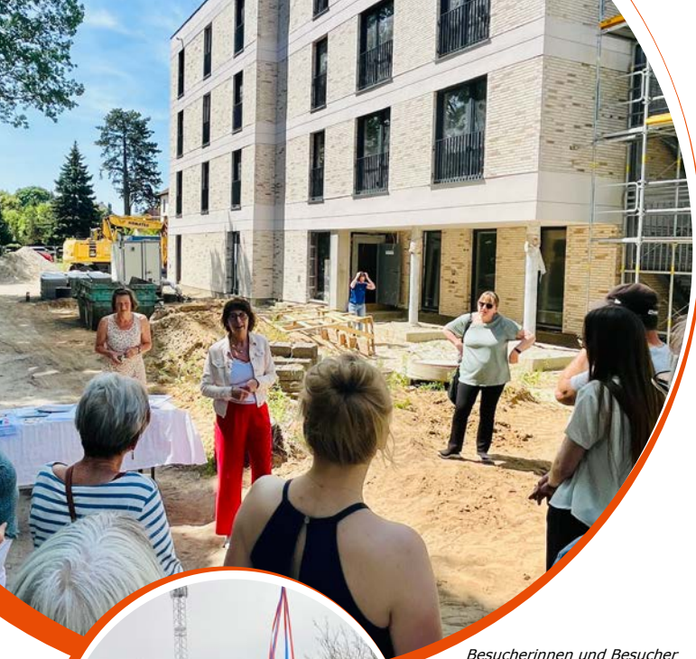
Besucherinnen und Besucher bei der Baustellenbesichtigung
