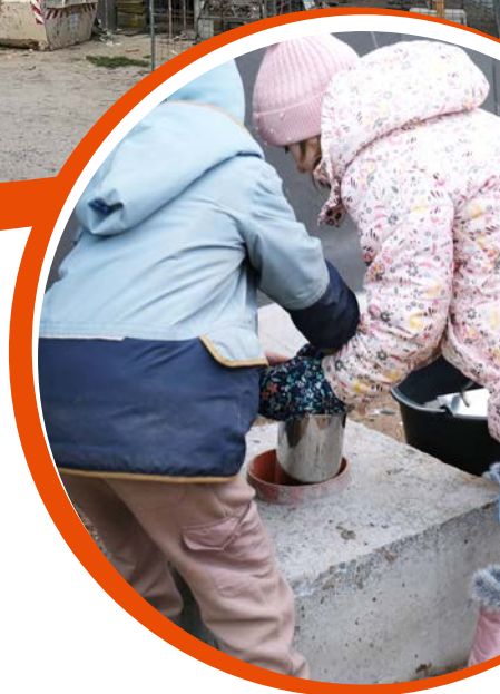
Kinder versenken die Zeitkapsel bei der Grundsteinlegung
