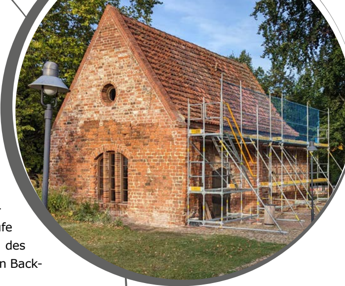
Im Zuge der Sanierung wurden die Dachgauben zurückgebaut.
